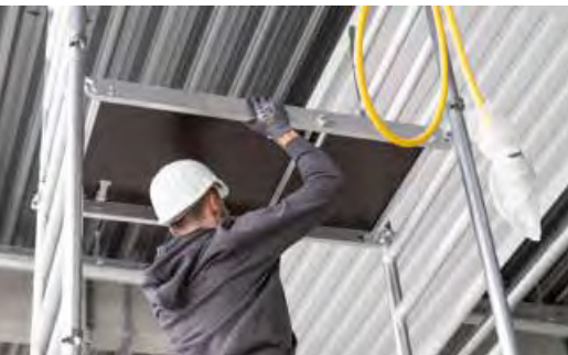
Weitere Aufsteckrahmen einsetzen Obere Plattform einhängen
