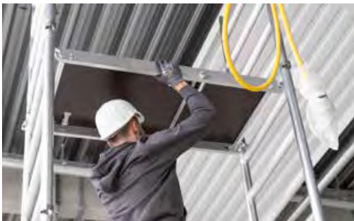
Weitere Aufsteckrahmen einsetzen Obere Plattform einhängen
