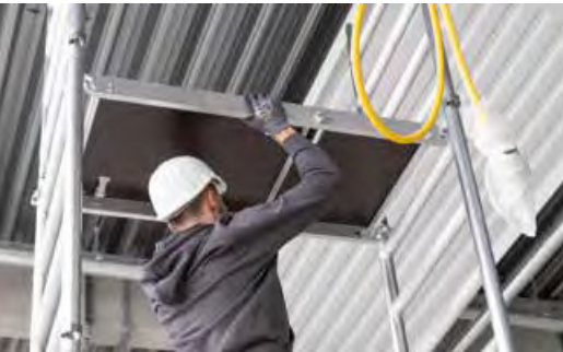
Weitere Aufsteckrahmen einsetzen Obere Plattform einhängen
